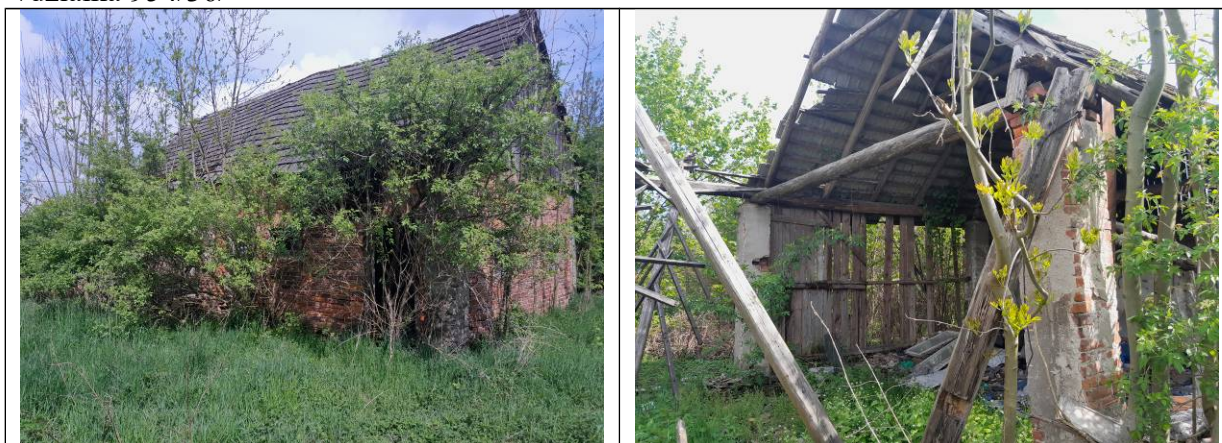
Budynek gospodarczy w ruinie, drewniano murowany. Powierzchnia zabudowy około 174m 2 . Stan techniczny zły.
